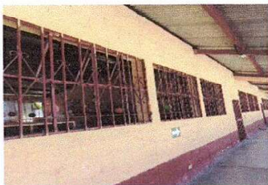
Foto 5: Ventanas de aulas
